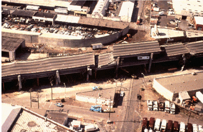
Abbildung 3.5: Einsturz des oberen Brückenträgers in Loma Prieta CA, 1989
