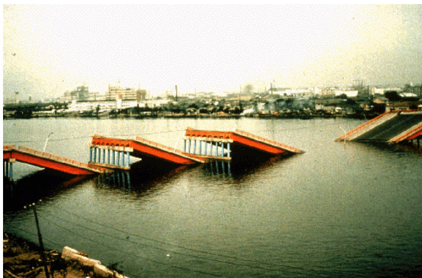
Abbildung 3.6: Absturz von Brückenträgern nach Erdbeben 1964, Japan
