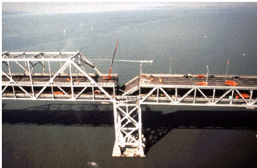
Abbildung 3.4: Absturz Brückenträger, S.F.-Oakland Bay-Bridge, 1989
