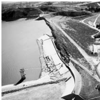
Bild 1: Lower-San-Fernando-Damm nach dem Erdbeben von 1971 in San Fernando, Magnitude M_w = 6,6 (Quelle: R. E. Wallace, U. S. Geological Survey, 1971)
