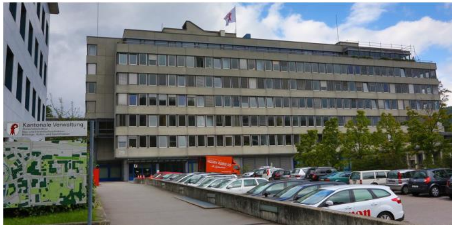
Vorderansicht des Verwaltungsgebäudes
